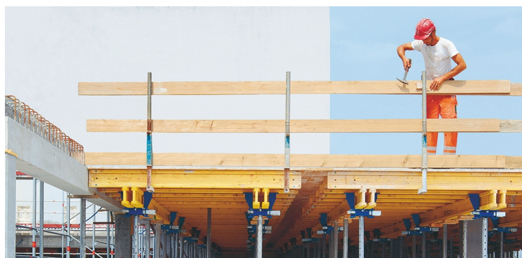
Figure 3.62 : Cas d'usage « Protection contre les chutes » – protection latérale sur un chantier
