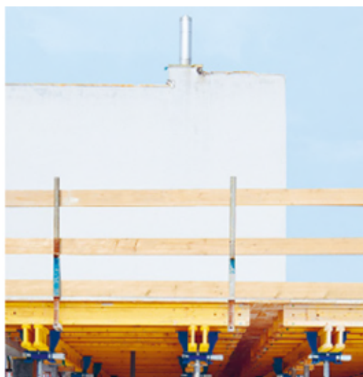
Mise en œuvre sur le chantier
