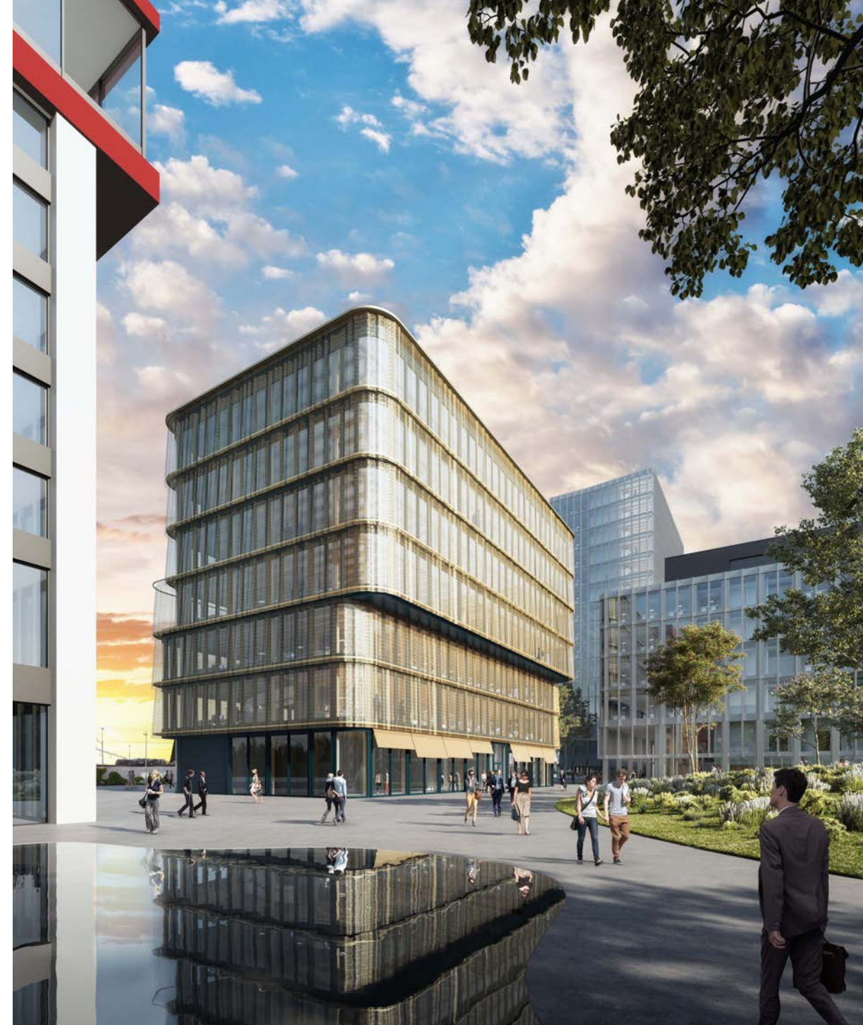
Gener Baufeld 1 Aussenansicht, hofseitig
