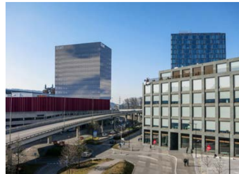
Glatt Tower Wallisellen ■ WR Architekten AG
