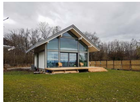
Construction d'une habitation ■ AEC architectes
