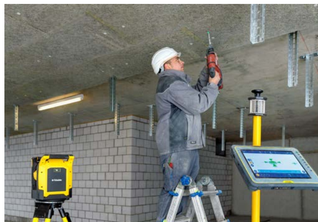
Rohrleitungsinstallations nach digitalem z-Mass-Prozess
