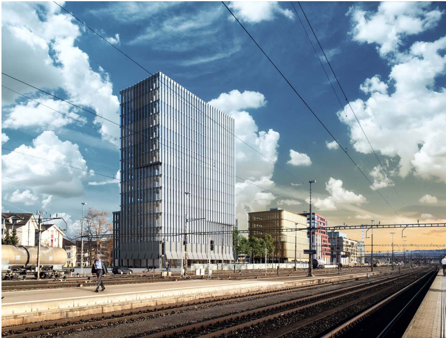
Baufeld 1 Aussenansicht, von Westen
